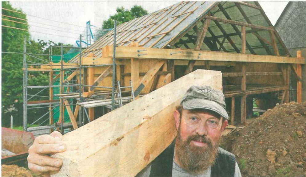
Frank Kutschke schleppt einen neuen Holzbalken auf die Baustelle in Rugiswalde. Die alte Scheune im Hintergrund wird derzeit zu einem Mehrzweckgebäude umgebaut. Den Bauleuten sitzt nun die Zeit im Nacken. Foto: Steffen Jäger
