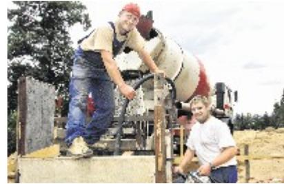
Im Juni wurden die sechs Fundamente der Liftpfeiler mit Beton ausgegossen und verfestigt. Damit ging der Bau in die heiße Phase. Archivfoto: Frank Baldauf
